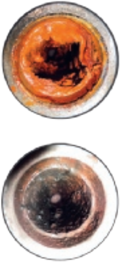
Intérieur de la conduite avant et après traitement
