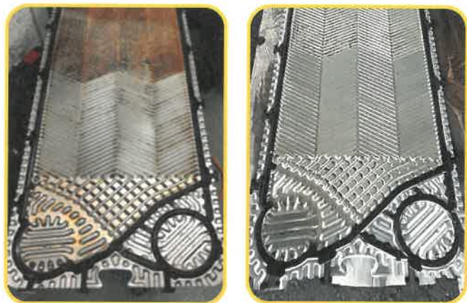
Platte nach der Reinigung mit Hochdruck-Anlage (li.) und dieselbe Platte nach 18 Monaten Betrieb mit Aqua4d.
